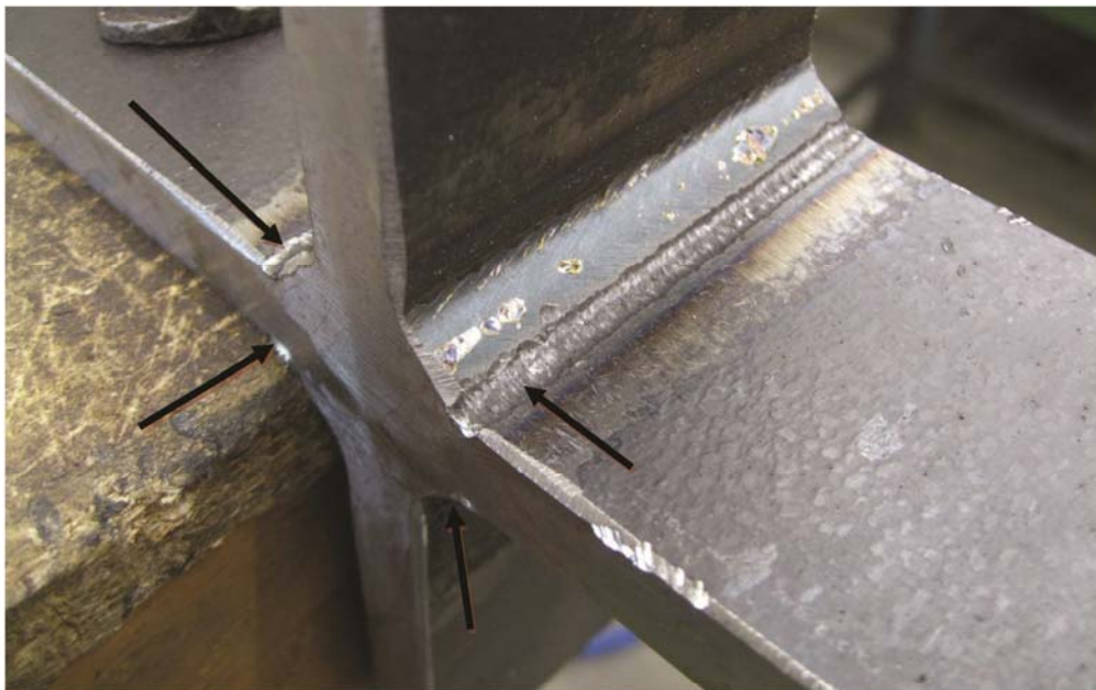
Bild 6: alle 4 Nahtübergänge am durchgehenden Blech wurden PIT behandelt (siehe Pfeile)
