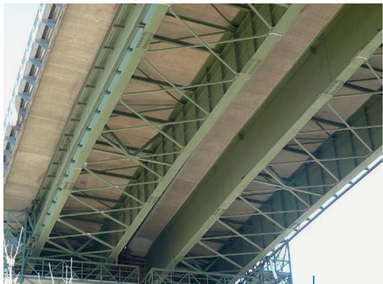
Bild 15. Stählerne Unterkonstruktion der Brücke
